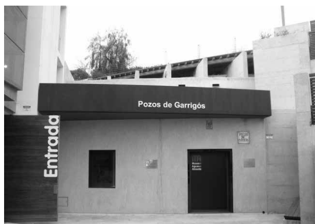
Pozos de Garrigós en la actualidad y antes de la última reforma
